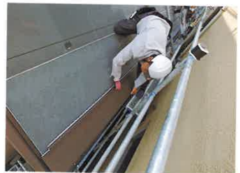
■狭小地の急勾配な住宅での不安定な体勢の施工例 スーパーガルテクトCはコンパクトサイズで軽量です。 施工が困難な狭小地でも簡単に施工することができます。
